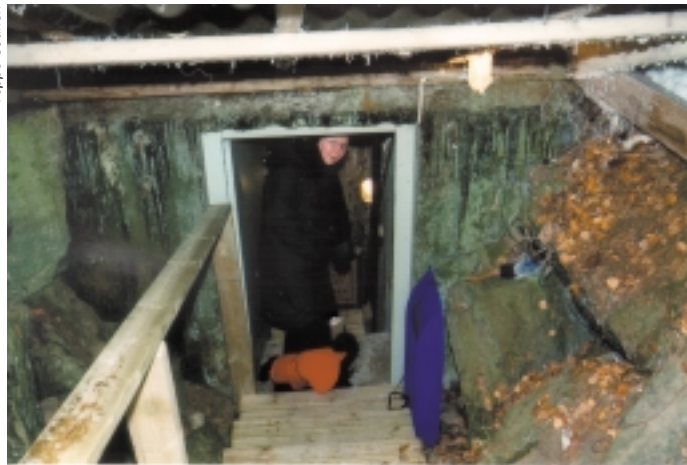
Bunkkerin sisäänkäynti vie maan alle, jossa betonia on vähintään metri joka suuntaan sekä kännykän kentän estävä Faradayn häkki.
